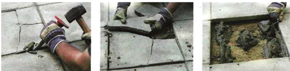
Рисунок 14. Ремонт покрытия на пескоцементном подстилающем слое
